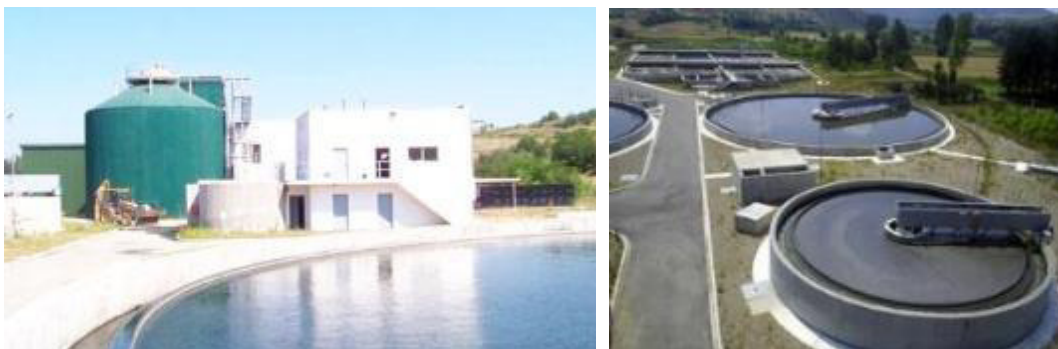
Слика 60 Пречистителна станица за отпадни води – Куманово
