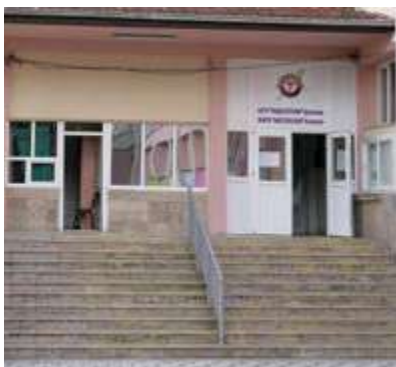
Извршена е замена на влезната врата.
