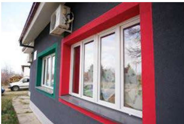
Поставени се комплетно нови ПВЦ врати и прозорци во ПУ „Карпош“ – с. Љубодраг.
