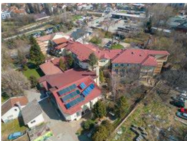
Надградба на постечкиот систем за соларно затоплување на вода до 2.5 тони.
