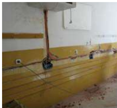
Целосно е заменета електричната инсталација во ПУ „Браќа Миладиновци“ – с. Пчиња.
