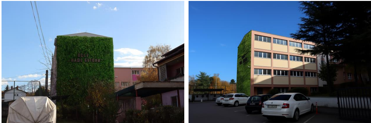
Слика 7: Изглед на објектот „Наче Буѓони“ со зелено решение
