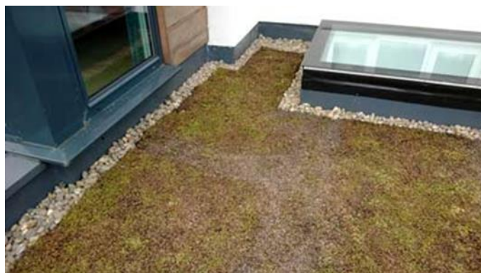
Слика 1: Камена рамка околу работ на кровот
