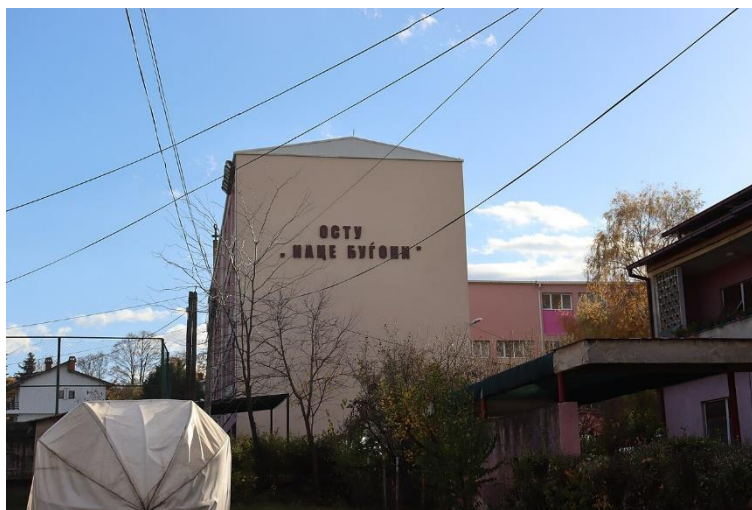
Слика 6: ОШУ „Наце Бугјони“ – реконструкција на фасада
